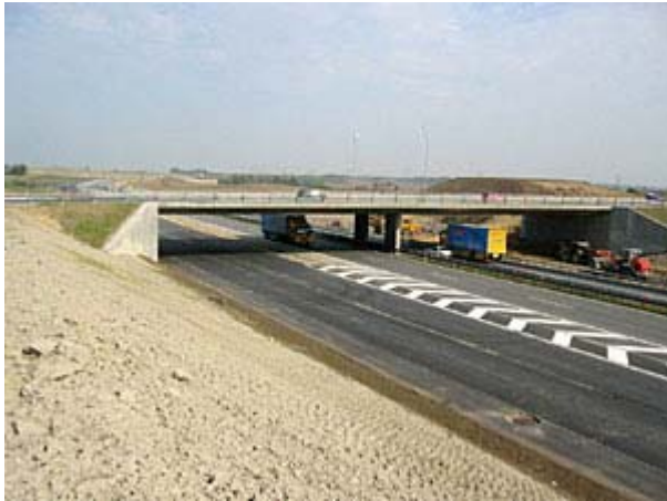
Silkeborgvejbroen ved E45 efter forlængelsen
