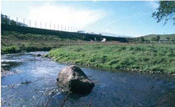
Støjskærm ved Lyngbygård Ådal - set fra Lyngbygård Å
