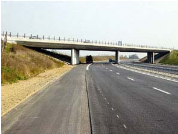
Silkeborgvejbroen ved Lillering. Skæringsvinklen gør det vanskeligt at fornemme broens længde.
