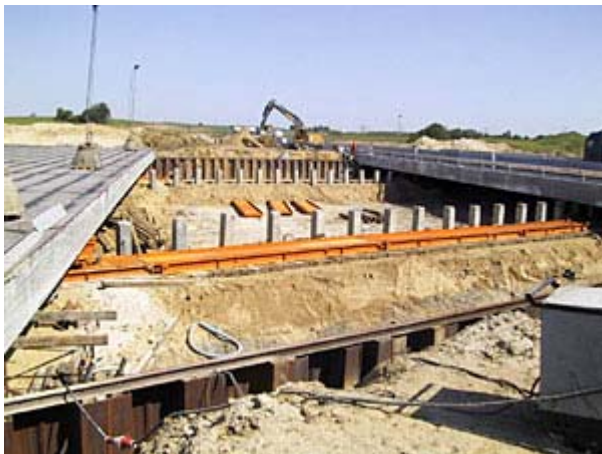
"Skubbebroen" ved krydsningen med Den Jyske Motorvej (E45). Vestlig broplade (til venstre) før flytning. Det østlige brodæk ses til højre. Underbygning af spuns og rammede pæle ses sammen med én af glideskinnerne for luftpudesystemet.
