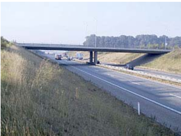
Silkeborgvejbroen ved E45 som åben bro for godt et år siden
