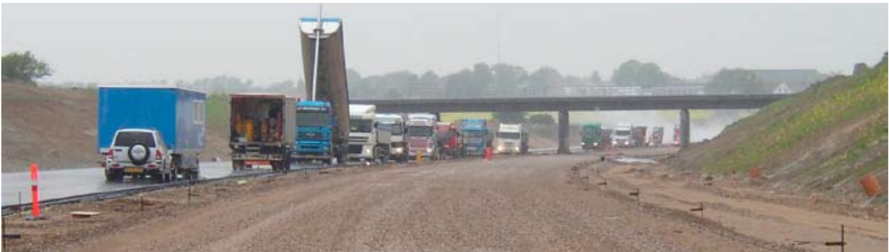
Udlægning af asfalt under banebroen
